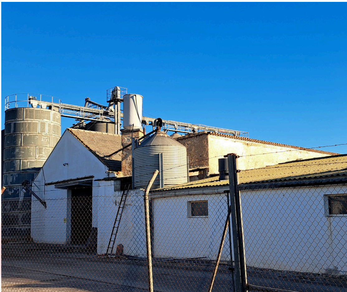
Figura 13.- Nave para la molinenda anexa en su lado sur a estructura de tapial de forma rectangular de 9 metros de altura.
