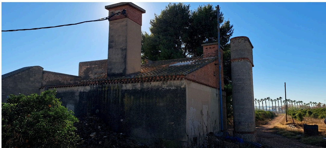
Figura 6.- Motor de la Gineta. Fachada trasera.
