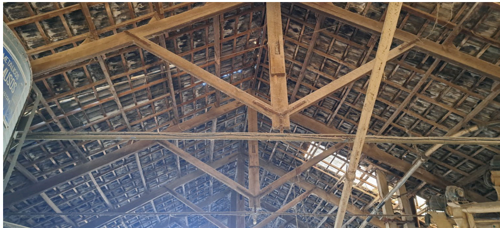
Figura 11.- Cubierta de madera del cobertizo para la molienda de piensos. Según propietarios, toda la cubierta se la trajeron de una vaqueriza anterior que tenían en Valencia.
