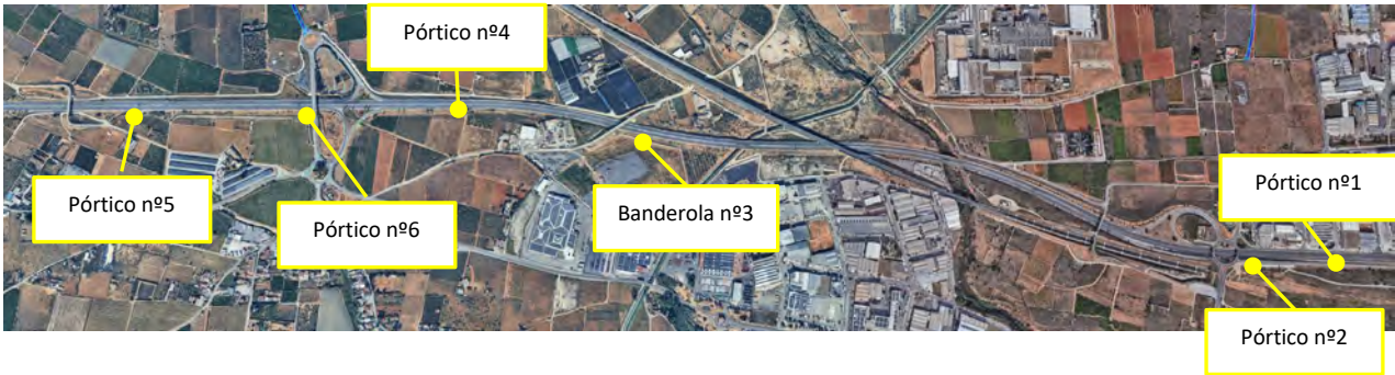
Figura 46.- Localización de los pórticos y banderolas de señalización cuyos destinos se propone adaptar.
