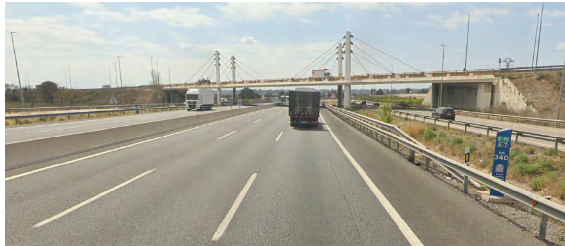
Figura 12 – Vista de la autovía A-7 en el tramo de enlace con la carretera CV-36 (Fuente: Street view).
