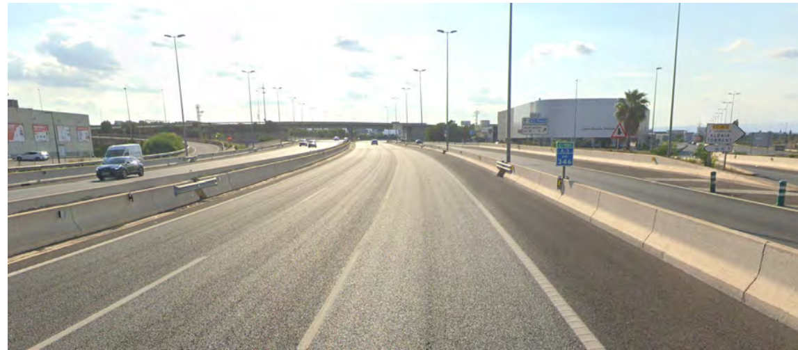
Figura 11 – Vista de la autovía A-3 en el tramo de enlace con la carretera CV-410 (Fuente: Street view).
