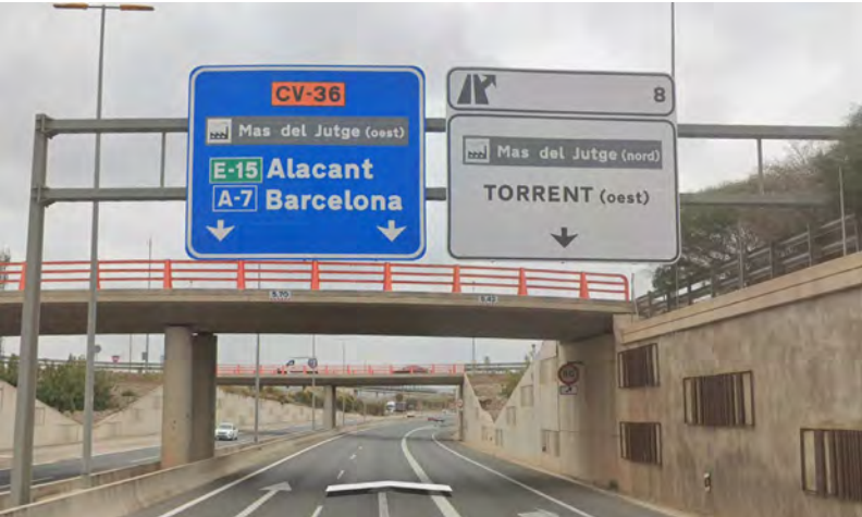
SEÑALIZACIÓN DE DESTINOS ACTUAL
