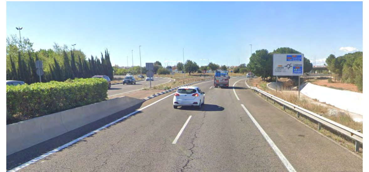
Figura 13 – Vista de la carretera CV-410 en las proximidades de la glorieta del enlace con la carretera CV-36 sentido CV-36 (Fuente: Street view).
