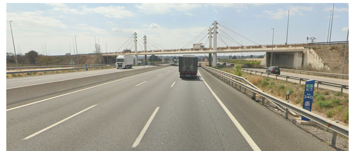
Figura 13 – Vista de la autovía A-7 en el tramo de enlace con la carretera CV-36 (Fuente: Visor GVA).
