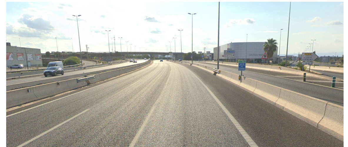
Figura 12 – Vista de la autovía A-3 en el tramo de enlace con la carretera CV-410 (Fuente: Visor GVA).
