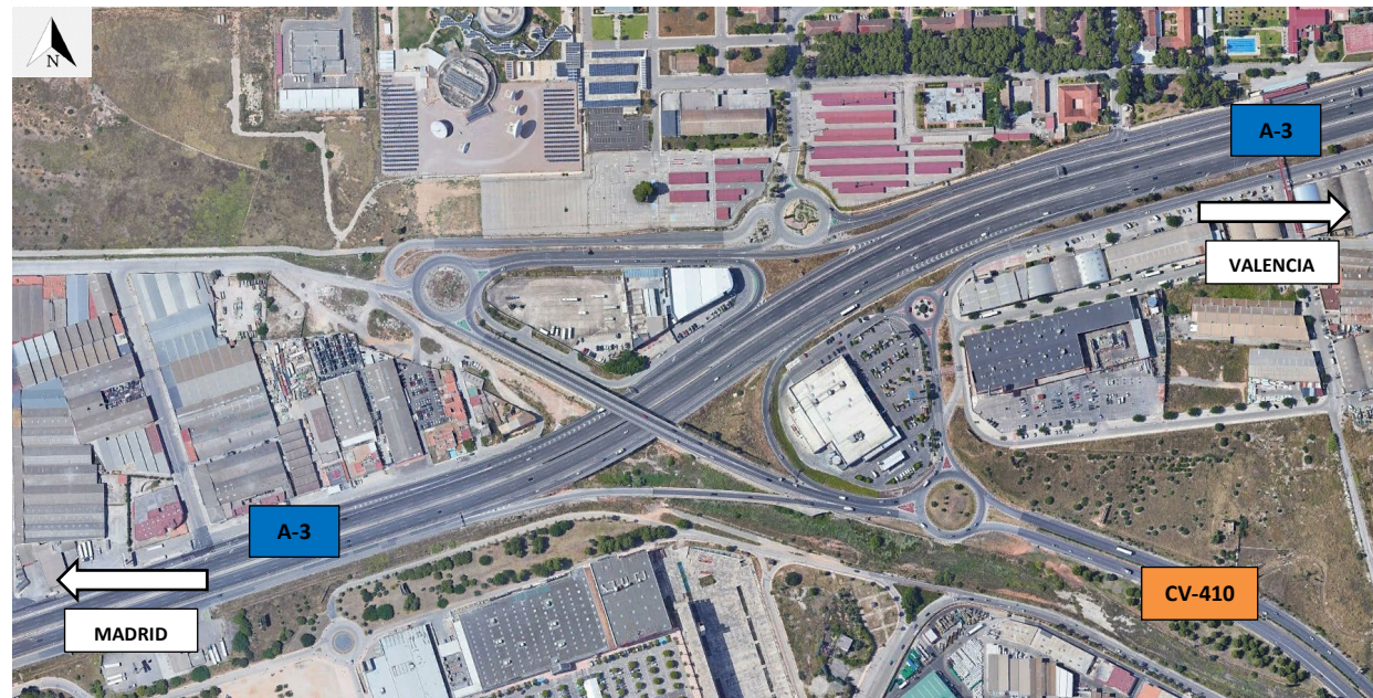
Figura 14 –Enlace de conexión de la A-3 con la carretera CV-410.
