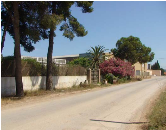
Foto 27: Zona 9. Naves abandonadas.
