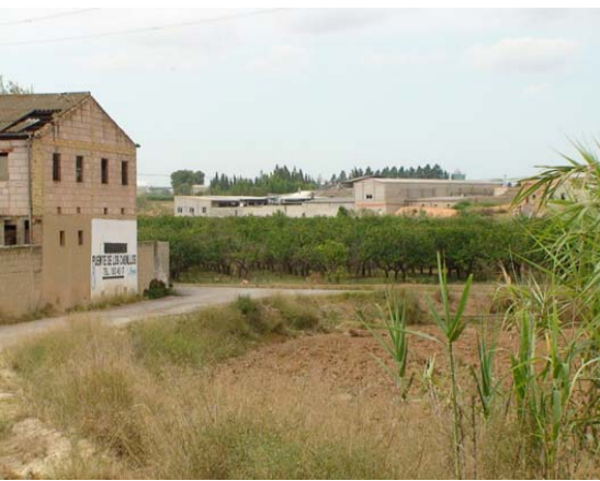
Foto 3: edificios abandonados en Ereta dels Moros.
