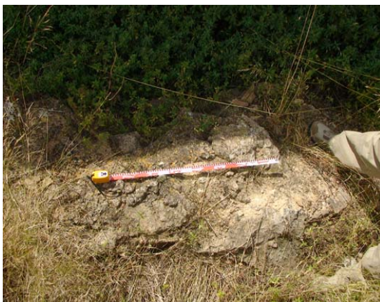
Foto 46: Zona 14. Detalle Opus caementicium .
