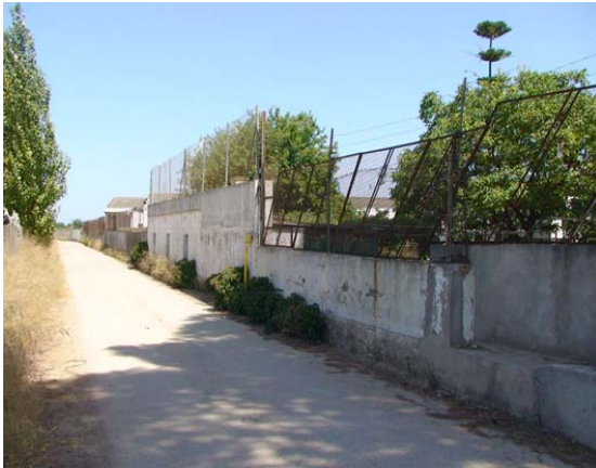
Foto 26: Zona 9. Naves abandonadas.
