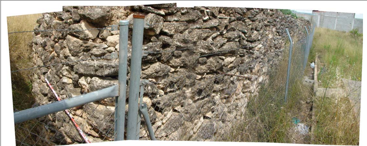
Foto 49: Zona 14. Panorámica del paramento murario.
