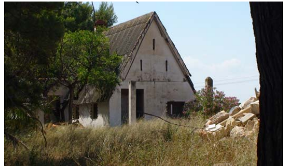
Barraca de morfología tradicional, pero de fábrica con ladrillos huecos y techumbre de uralita.
