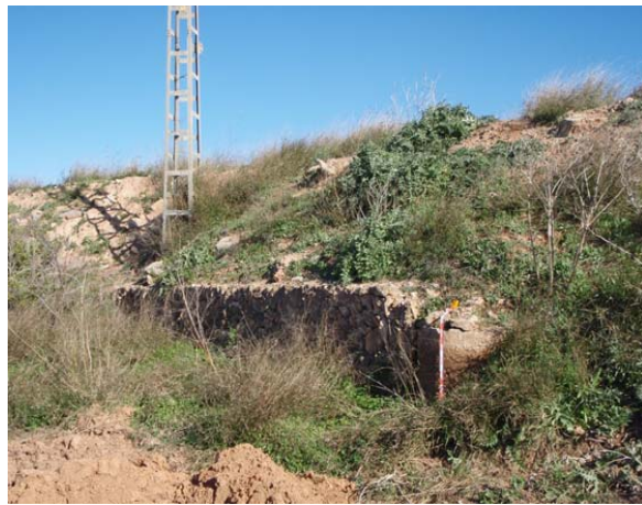
Foto 7: Situación columna nº 3, Ereta dels Moros III.
