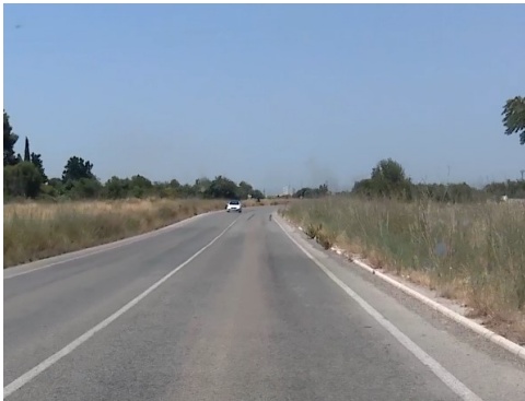
15- Corredor Ind. sentido norte. Fuente.- Elaboración propia.
