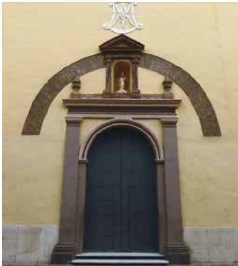
8 Porta principal situada al carrer de l'Església.
