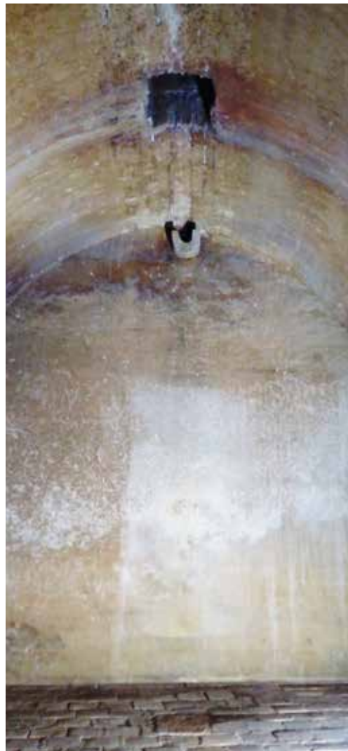
Interior de la Cisterna, mirant cap al Nord i cap al Sud, on es troba la gàrgola de subministrament.
