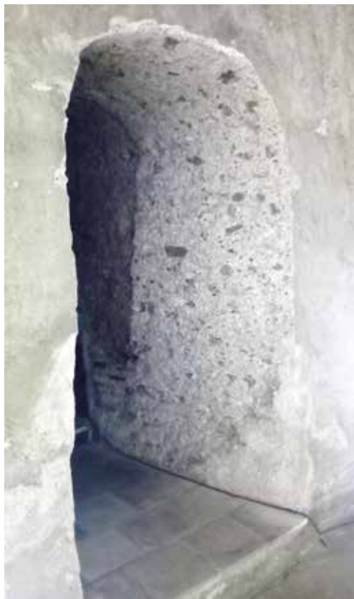
Mur que separa el depòsit de la zona de les aixetes.
