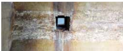
Apertura a la volta per a accedir en origen al depòsit.
