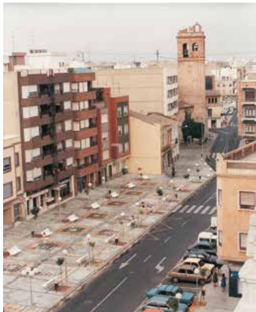
Imatge de l'any 1994 on s'aprecien les obres de reurbanització de la plaça.
