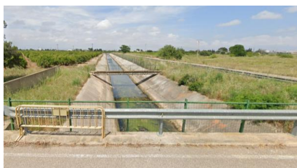
Canal en su paso al cementerio
