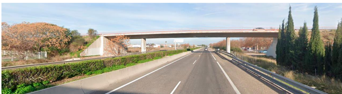
Pasarela aérea en CV-33
