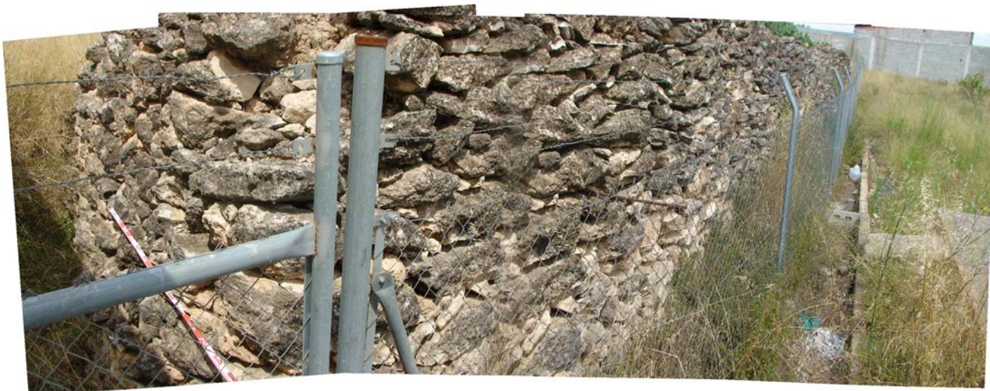
Panorámica del paramento murario de piedra seca. Fotografía tratada digitalmente.
