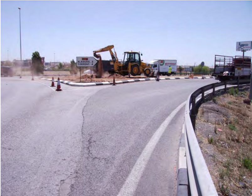
Foto 11. Detalle de obras en isletas de la rotonda R01, ramal C acceso CV-33
