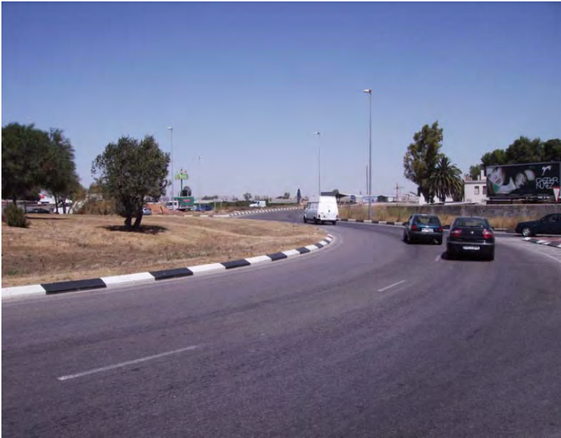
Foto 5. Vista general de la rotonda R01, desde su ramal de acceso D. Dos anchos carriles de circulación interna
