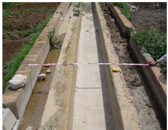
Foto 51: Zona 16. Sistema de acequias con tres canales.
