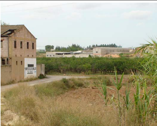
Foto 3: edificios abandonados en Ereta dels Moros.
