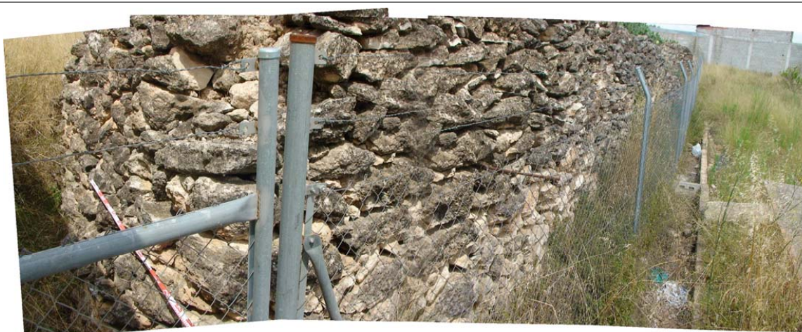
Panorámica del paramento murario de piedra seca. Fotografía tratada digitalmente.
