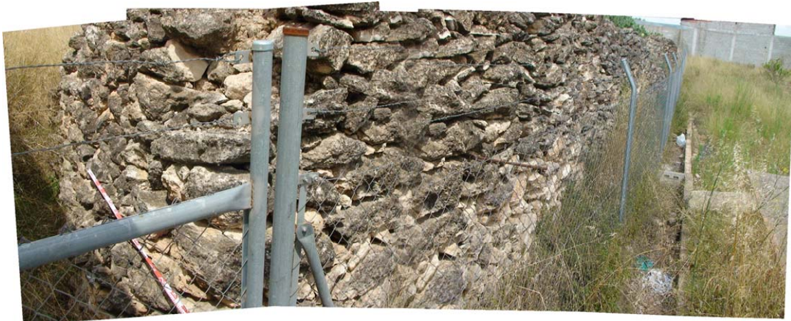
Foto 49: Zona 14. Panorámica del paramento murario.
