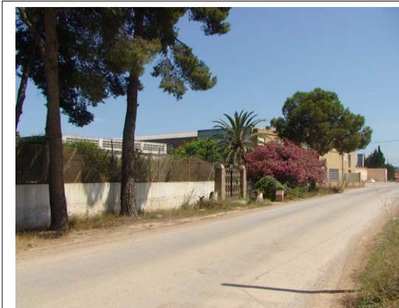
Foto 27: Zona 9. Naves abandonadas.
