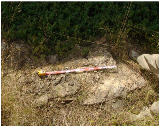
Foto 46: Zona 14. Detalle Opus caementicium .
