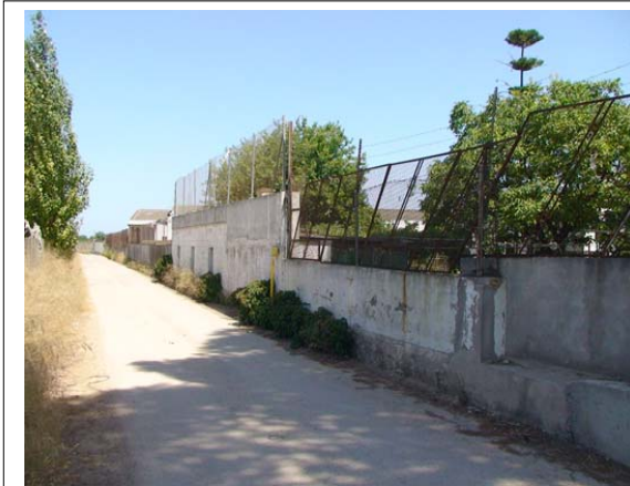
Foto 26: Zona 9. Naves abandonadas.
