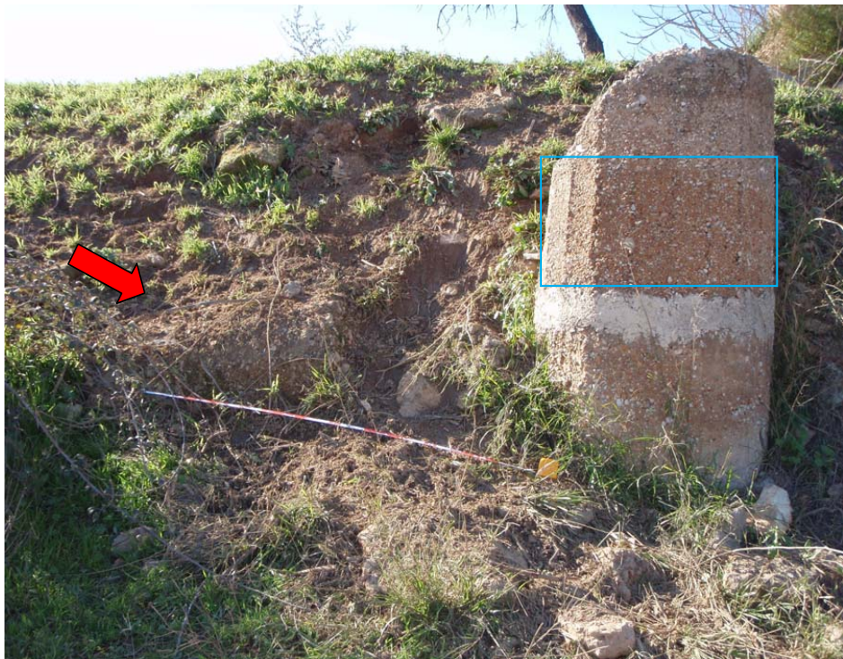
Foto 2: Ereta dels Moros III. Restos de columna nº 1. Se aprecian huellas del encofrado. El recuadro azul es ampliado en la foto 3.
