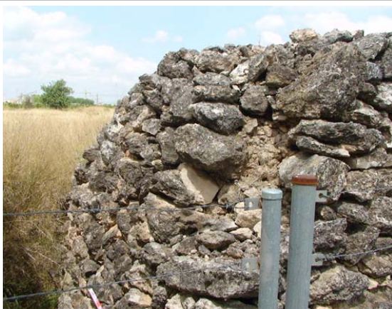
Foto 47: Zona 14. Detalle del muro de piedra seca con relleno de arena, limos y gravilla.
