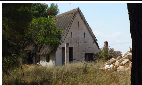
Barraca de morfología tradicional, pero de fábrica con ladrillos huecos y techumbre de uralita.
