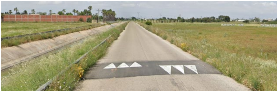
ACCESO ACTUAL AL CEMENTERIO ALDAIA
