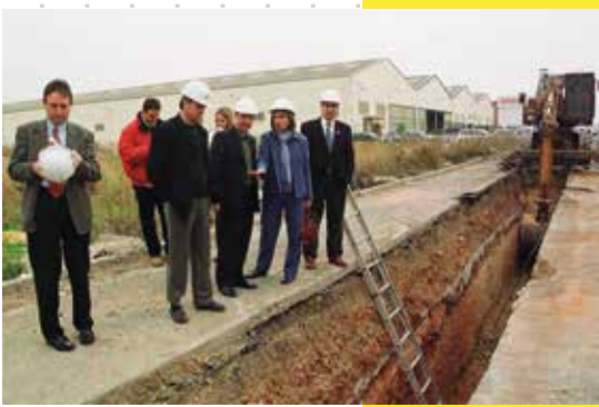
Obres de canalització del barranc en el polígon de Quart -la pota del ciutadà- acompanyen a l'alcaldessa Carmen Martínez, el president dels empresaris Requleme.
