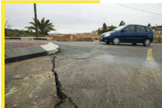
Coriment de l'asfalt de la rotonda de l'AVE a Alaquàs, ja que va subterrani per aquesta població.
