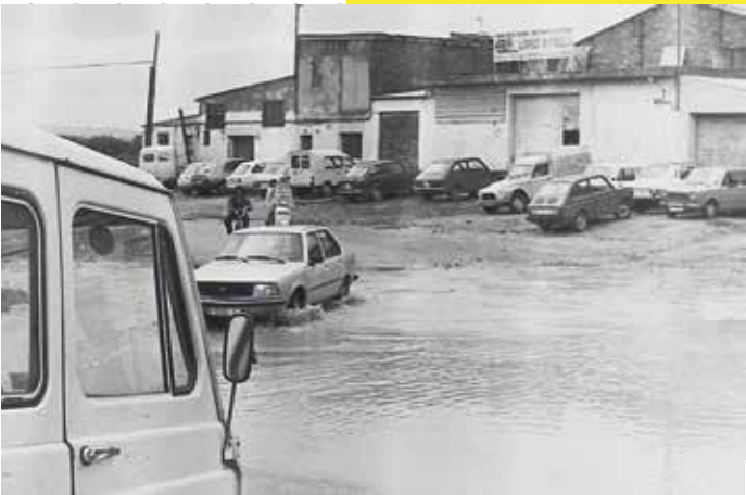
Inundació de les fabriques de l'entorn del barranc de la Saleta a Aldaia.
