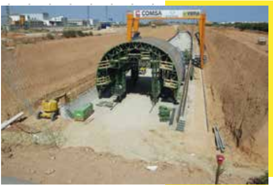
Obres en Alaquàs d'enterrament de l'AVE al pas entre Torrent - Aldaia - Alaquàs
